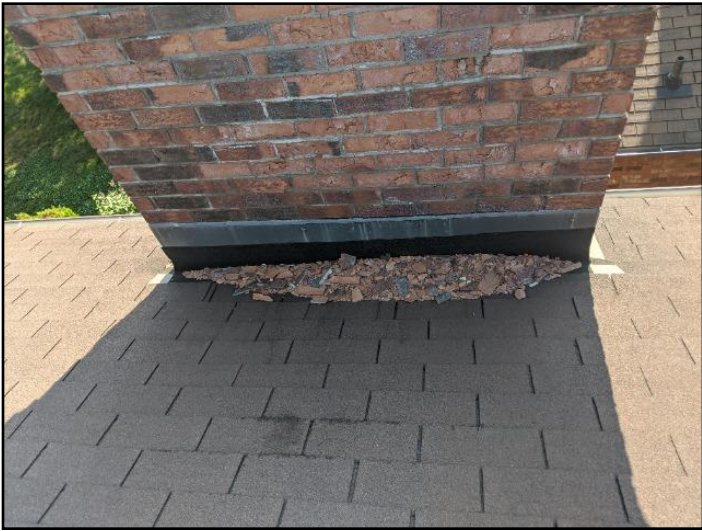
13. Spalling
